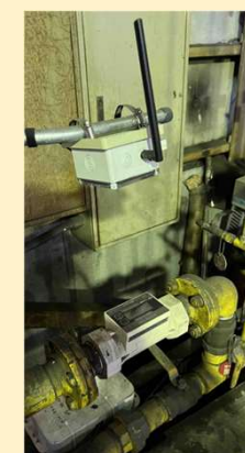
ガスメーターとカメラの様子 ガスの使用量をカメラで撮影し、AI解析
